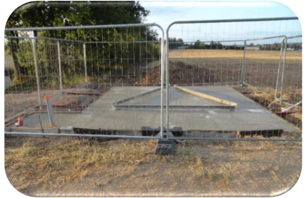
qui a été réalisé. Ce sont 30 m<sup>3</sup> de béton qui ont été coulés pour maintenir les 3 points de fixation du pylône. Après un temps de séchage de 4 semaines, la mise en place du pylône devrait intervenir début octobre. Ne restera plus qu'aux opérateurs à venir implanter leurs antennes...
